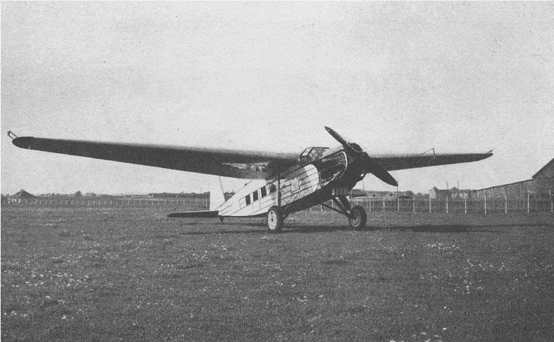
*Le M-20b se distinguait du M-20a par une aile possédant un dièdre plus important, des empennages modifiés et un train d'atterrissage plus haut.*
