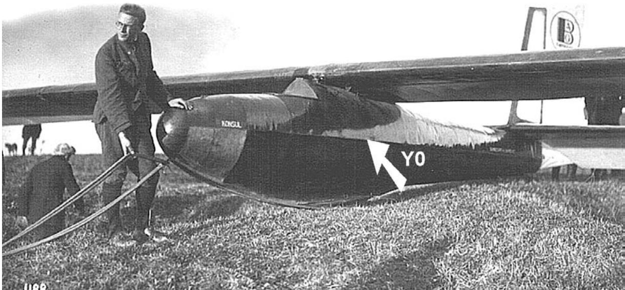
Sur la photo de ce fuselage construit en structure a partir de couples, de lisses et de panneaux de contreplaqué, la ligne Y0 apparait grâce aux reflets lumineux comme parfaitement rectiligne
