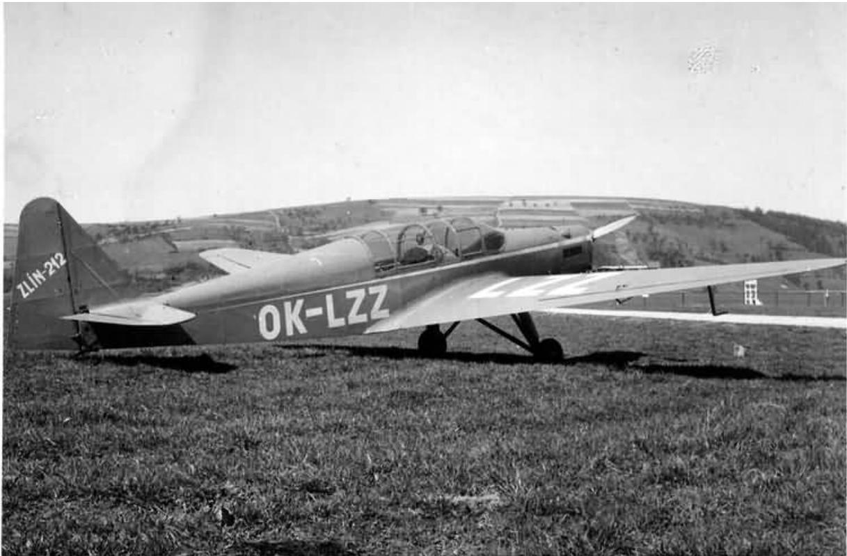
Arborant une livrée rouge rehaussée d'un peu de blanc, la tête de série Zlin 212 fut un des trois appareils de ce type à figurer sur le registre aéronautique de Tchécoslovaquie. Ce modèle ne se distinguait du Zlin XII que par sa motorisation, identique à celle du second prototype de 1935.
