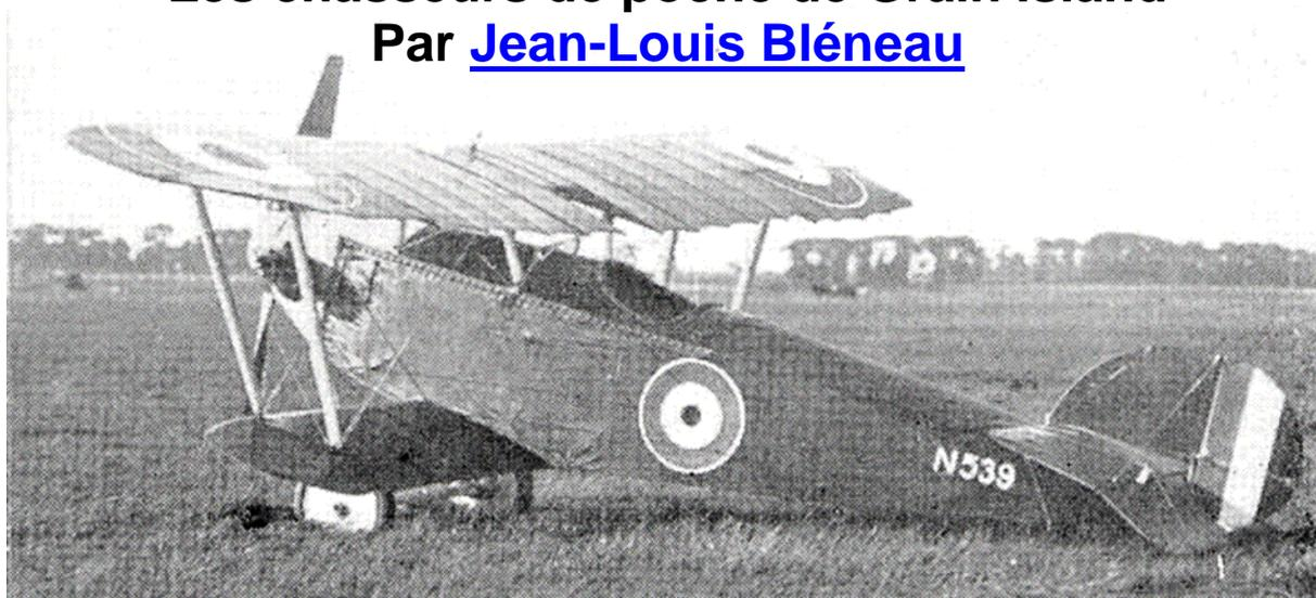
Vu sous cet angle le prototype P.V.7 ne semble pas se distinguer des nombreux monoplaces testés durant la Première Guerre mondiale. Son moteur est pourtant un bicylindre de 35 ch, ce qui en ferait aujourd'hui un modeste biplan de construction amateur. L'armement ne fut jamais installé.
