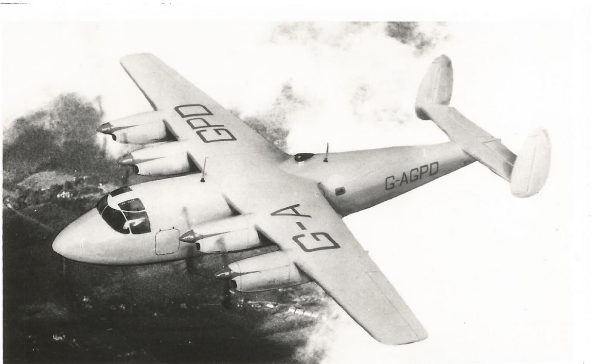
Diffusée en 1946 par Miles Aircraft, cette photo légèrement retouchée du premier prototype M,60 Marathon (c/n 6225) confirme que ce quadrimoteur de transport d'apport avait bien initialement un empennage bidérive. Ce prototype effectua son premier vol le 19 mai 1946 avec une immatriculation provisoire (U10). Il fut perdu sur accident le 28 mai 1948.
