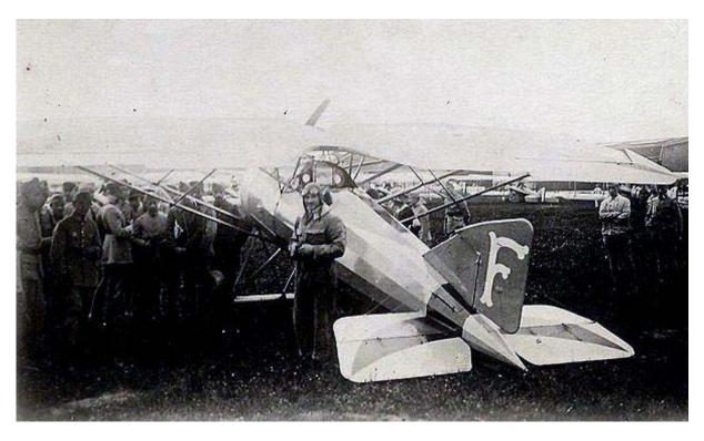
Il passe à peu près bien tout ce qui est voltige de base, mis à part le renversement. Son moteur, en effet, constitue un gyroscope extrêmement puissant dont la précession se révèle gênante au cours de toutes les manœuvres impliquant un rythme de tangage important, et interdit rigoureusement toute rotation en lacet à faible vitesse.
